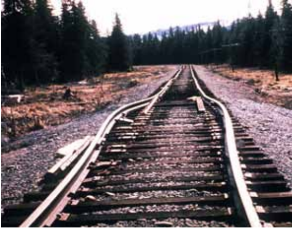
■ الشكل 19-2 تسبب درجات الحرارة العالية أيام الصيف الحارة تقوس مسارات سكة الحديد.
